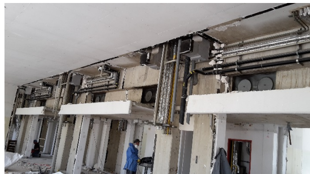
Leitungsführung vor dem Abbruch
